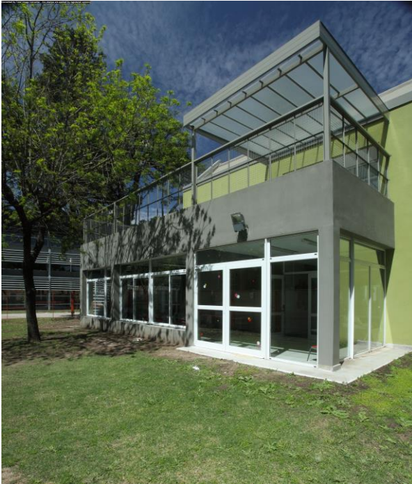
Foto 1 : vista de frente actual de la terraza
