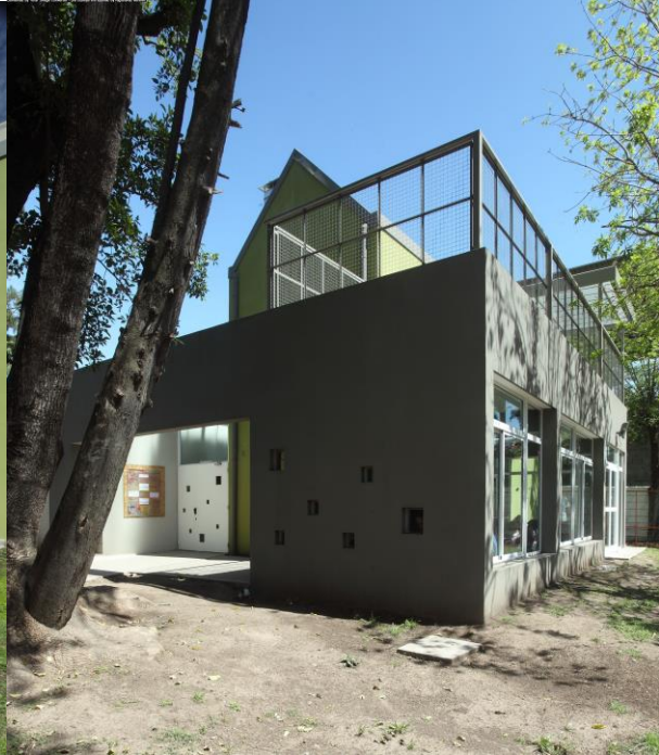
Foto 2 : vista lateral actual de la terraza
