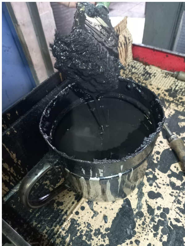
7. Pintura “flu” para nivelar.
