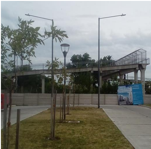
Foto: Puente a ninguna parte. Foto: Jose Bao
