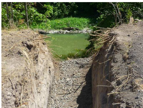
Apertura de canales en la cuenca media.
