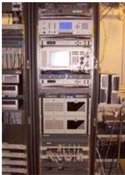
Figura J.3: Rack con equipos para encoder y MUX previa a la subida satelital.
