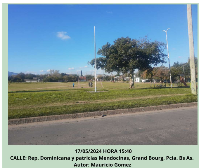
Figura 15. Luminarias de la plaza de P. Mendocinas y R. Dominicana.
