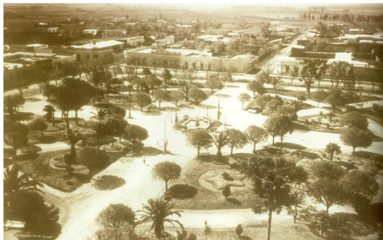
Foto 1. Vista obtenida desde una de las torres de la Iglesia de la Virgen de Pilar.
