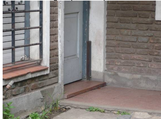
Foto 21. En el marco de la puerta se observa una guía para compuerta.
