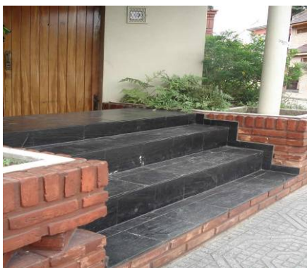
Foto 13. Vivienda con escalera piramidal
