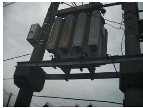
Foto nº - 18. Aguas Argentinas 1734 entre Ratti y Darbon. Salida de Campo sábado 8/11/03 Bº San Alberto
