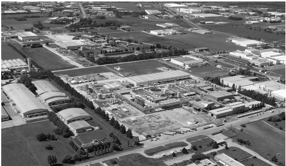
Imagen 15.5a. Vista aérea de un parque industrial
